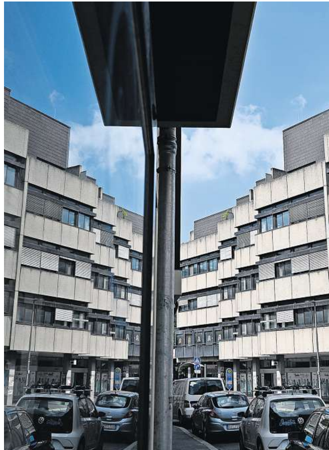
Seit Jahren steht das ehemalige Gothaer-Haus in der Göttinger Innenstadt leer. Verschiedene Eigentümer sind mit ihren Nutzungskonzepten gescheitert. Nun hat die Getec Immobilien GmbH aus Hannover die Immobilie gekauft. FOTO: SWEN PFÖRTNER
